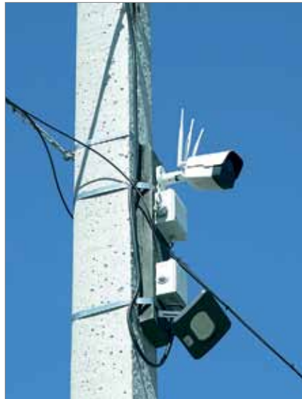
Типовая организация системы удаленного видеонаблюдения на стройплощадке
